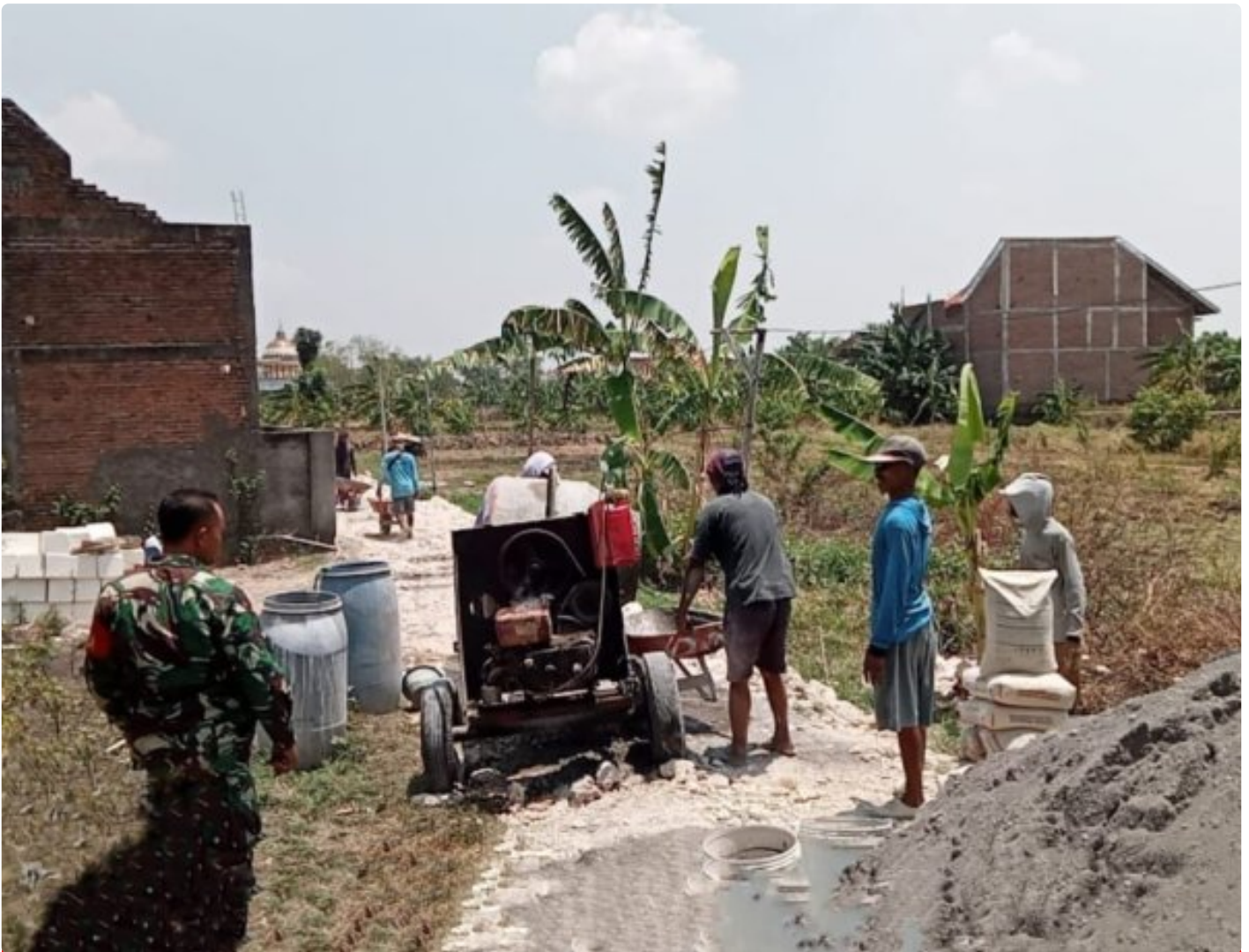
Babinsa Koramil 02/Bonang Kodim 0716/Demak Sertu Suwignyo Monitoring wilayah sekaligus memantau perbaikan jalan di Desa Jatumulyo Kecamatan Bonang Kabupaten Demak
